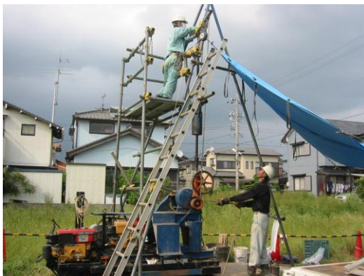
排水計画の検討に伴い市が行なったボーリング作業
